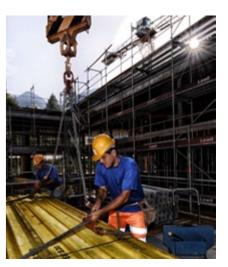
L'opera in sintesi: Superficie per piano 1000-1200m2 (stabile di 4 piani) - 3800 m2 casseri per pareti - 3600 m2 casseri per solette 390 ton di ferro d'armatura - 2800 m3 di calcestruzzo dalla centrale - 49 pilastri prefabbricati - 480 ml di elementi prefabbricati in curva Commitente: Fondazione Opera Mater Christi - Progetto architettonico: Mario Campi Architetto FAS Associati SA – Architetti Pellegrini & Partners SA
